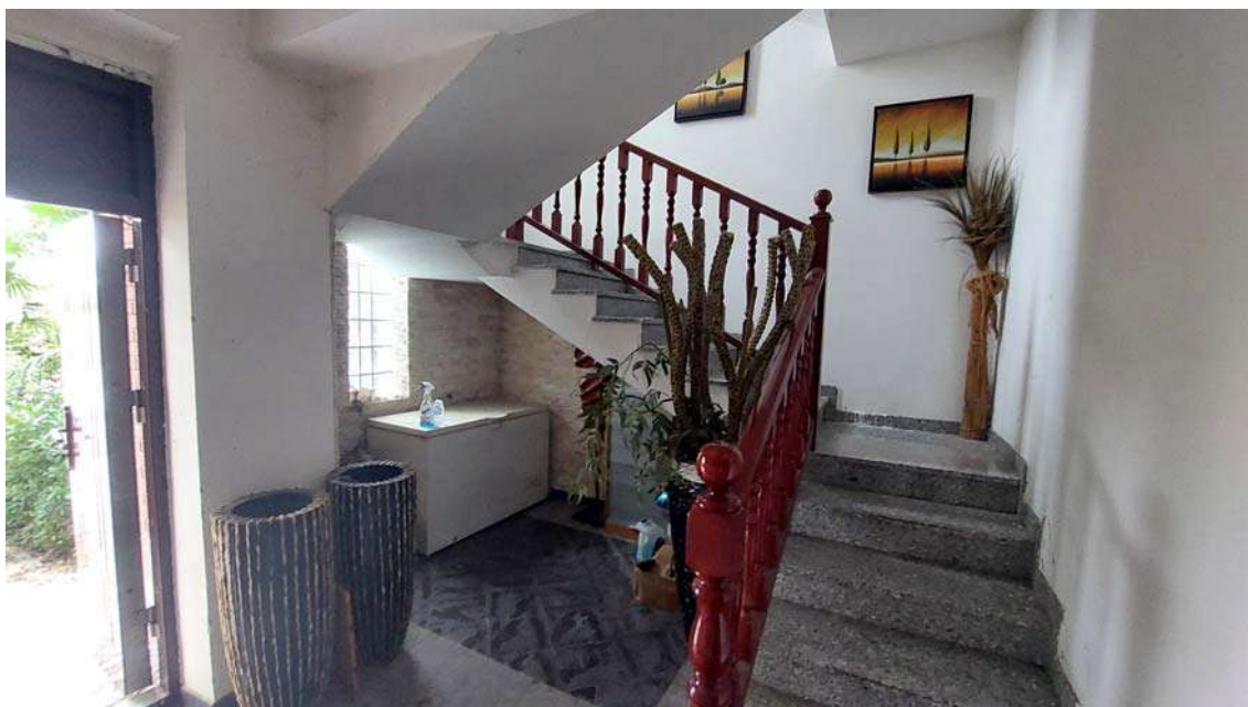
21) Vista del vano scala al piano terra.
