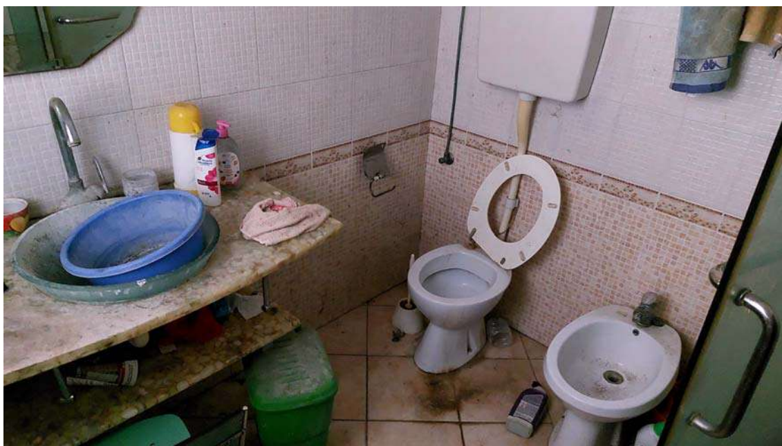
20) Vista del bagno del laboratorio.
