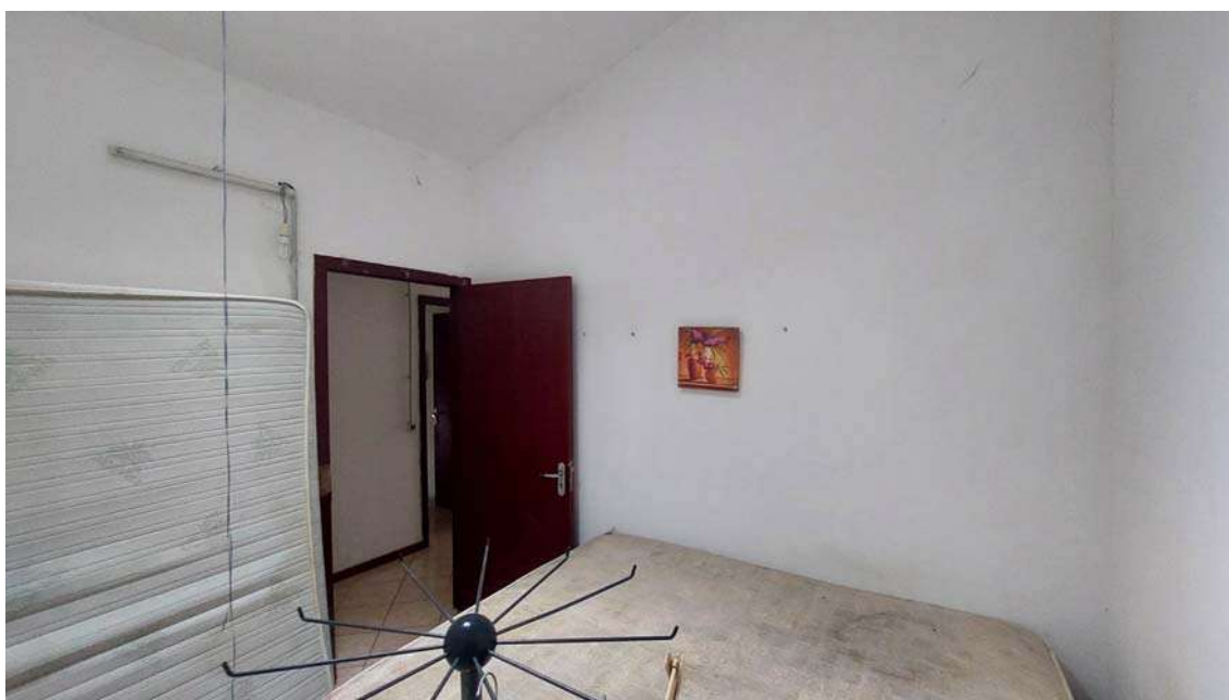
8) Vista di una soffitta al 2° piano.
